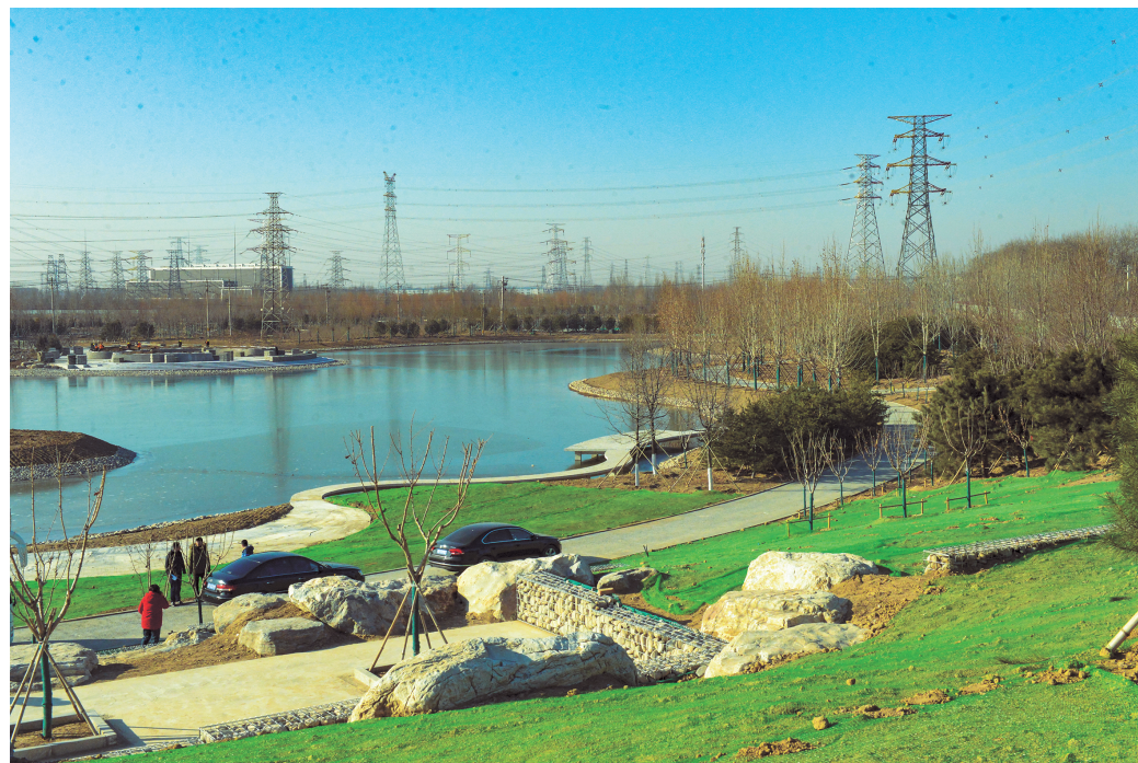
狼堡公园总建设面积5508亩,今年5月正式开工建设。截至目前,已整理公园地形67个,建设公园园路19156米,建设水系面积230295.14平方米,建设绿地灌溉管线43964米,栽植常绿及落叶乔木34762株。年底项目主体工程全部完成。
